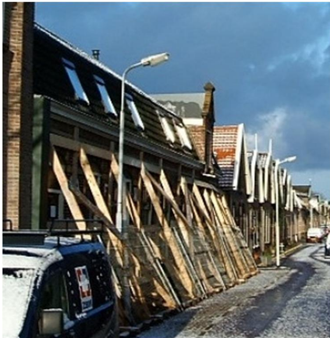
Paalrot bij grondwaterstandsverlaging in Zaanstad (bron gem. Zaanstad)
